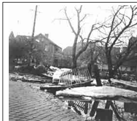
Nach dem Hochwasser Verwüstungen vor dem Gemeindebüro Neuhaldensleber Straße
